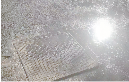
辽河路与舟山路交叉点，污水外溢。
