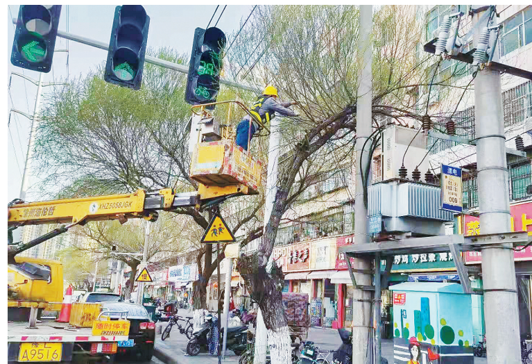
2月18日至25日，市路灯维护中心开展“促安全抓生产、排除安全隐患”活动。8天时间，他们共清除变压器周边安全隐患106处，更换避雷针6套。图为2月25日，工作人员在交通北路与海河路交叉口，清理变压器旁边的树枝。
