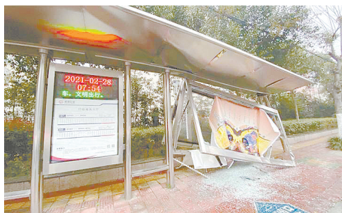
黄山路与淞江路交叉口向南100米路东,公交站牌损坏。
