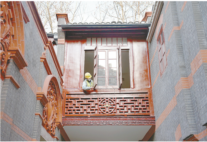
3月22日，工人在修缮现场施工。位于上海兴业路76号的中共一大会址自2020年11月17日起暂停对外开放，实施修缮改造，目前工程已进入收尾阶段。 新华社记者 刘 颖 摄
