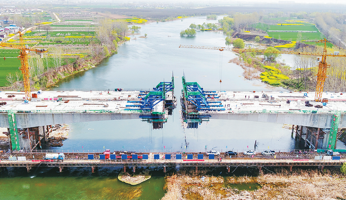
位于郾城区龙城镇冯湾村南的新西环沙河大桥,是西环(S222开环线)项目的重要节点工程,也是我市单跨最大的桥梁。桥梁全长897.24米,宽32.5米,目前南北主跨即将合龙。 本报记者 焦海洋 摄
