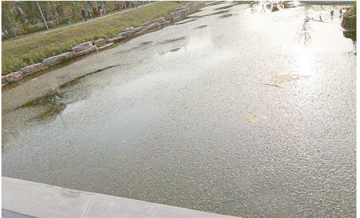
鸿安花园门口幸福渠，垃圾、水草多。
