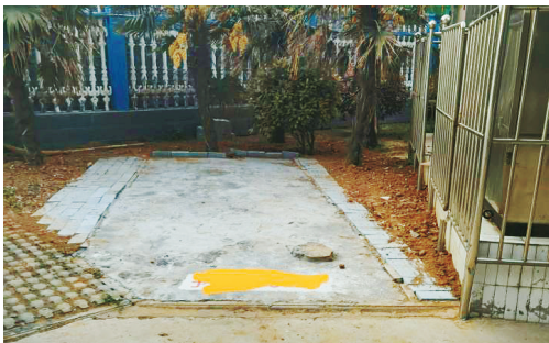
交通路南段龙腾馨苑小区，住户毁坏绿地私建停车位。
