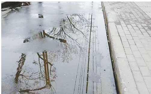
泰山路市实验中学附近天地顺超市门口,人行道上污水横流。
