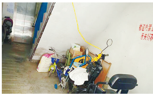
泰山路与湘江路交叉口丽景苑小区,存在飞线充电现象。
