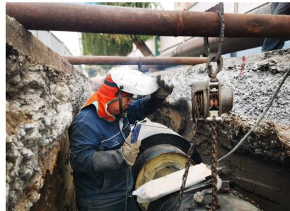
6月14日,集中供热施工人员正在交通北路焊接供热管道。据了解,交通北路(辽河路—黄河路)热力管网工程全长380米,截至目前已完成管道安装220米,预计6月底竣工。
