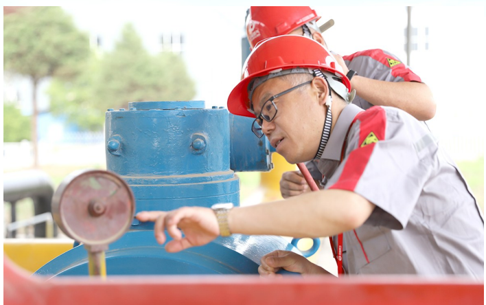
总经理毛海军在加气站排查安全隐患。
