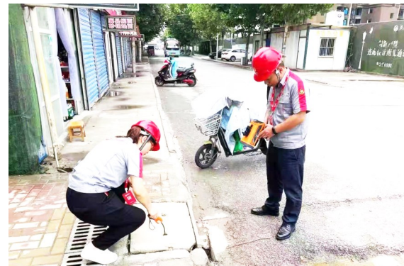
工作人员使用检漏仪对燃气管道进行泄露检测。
