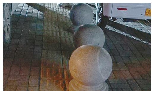
金色龙湾二区门口,石墩侵占盲道。
