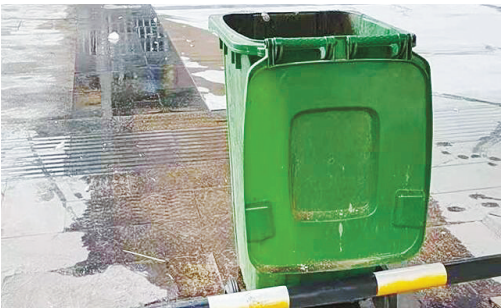
滨河路与乐山路交叉口，污水管道堵塞，臭气熏天。
