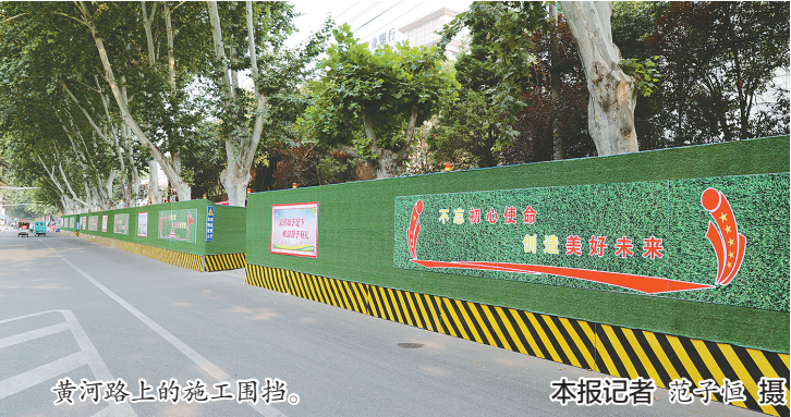
黄河路上的施工围挡。
