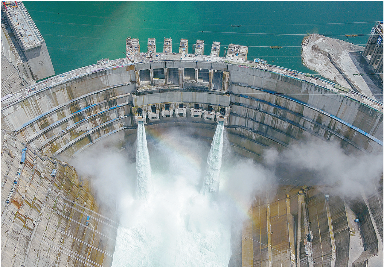
金沙江白鹤滩水电站首批机组于6月28日安全准点投产发电。图为6月10日拍摄的白鹤滩水电站（无人机照片）。新华社记者 胥冰洁 摄
