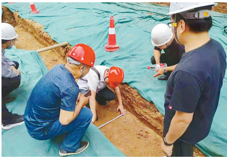
质检人员检查沟槽开挖质量。
