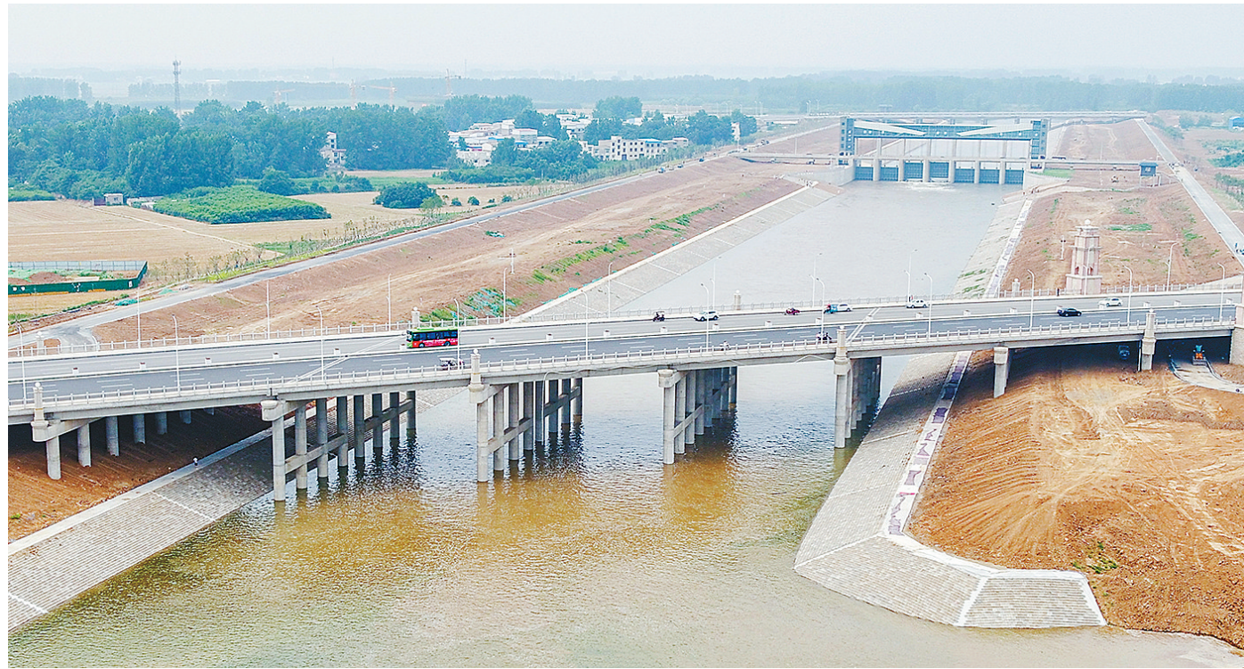
沙澧连通工程正式通水。
