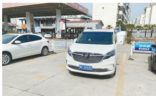
舟山路中石化加油站,机动车占压消防通道。
