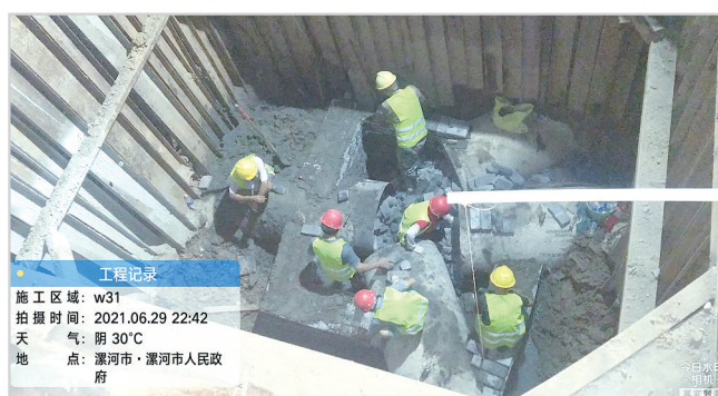
工人砌筑检查井。
