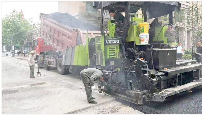
工人正在进行路面恢复作业。
