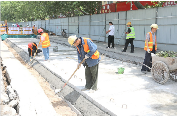
工人在回填作业。
