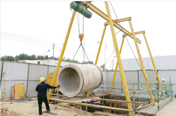
工人正在进行管道吊装作业。
