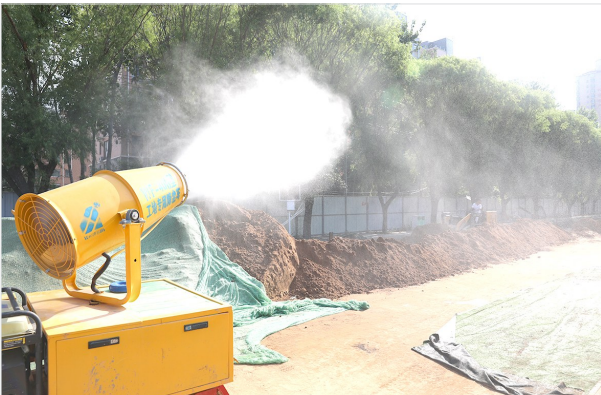
施工现场严格落实湿法作业。
