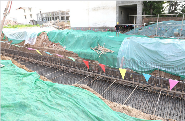
雨污分流施工现场。
