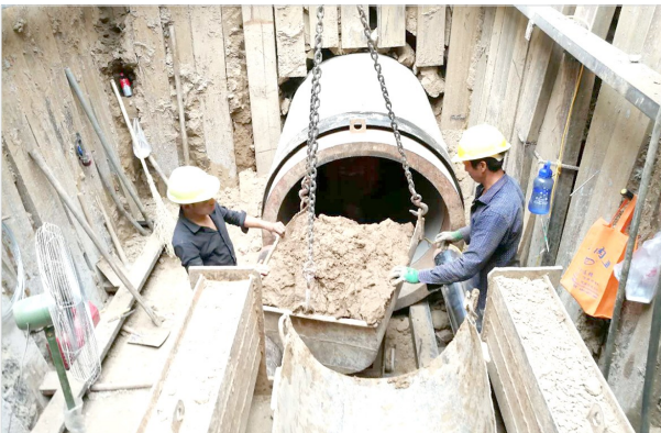
工人正在进行管道顶进作业。
