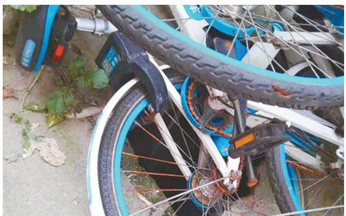
泰源星河湾小区5号楼附近，窨井盖缺失，有人用共享单车遮挡。
