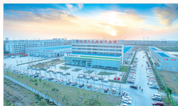
亿通汽车科技产业园
