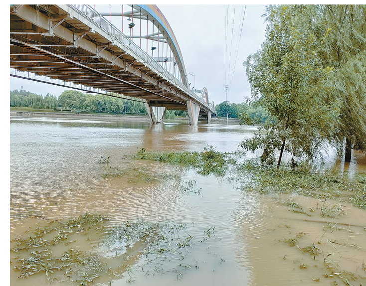
受强降雨影响，自8月30日11时开始，我市沙澧河上游白龟山水库、前坪水库、燕山水库、孤石滩水库及北汝河大陈闸同时泄洪。我市通过严密会商，精准调度沙河马湾拦河闸、沙河节制闸，将过境洪峰由每秒1520立方米削减为每秒1310立方米。截至9月1日下午，洪峰已平稳通过我市。
