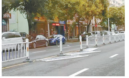
舟山路与辽河路交叉口向北约130米，交通护栏损坏。
