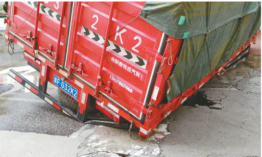
解放路君悦府,污水盖板被压坏。
