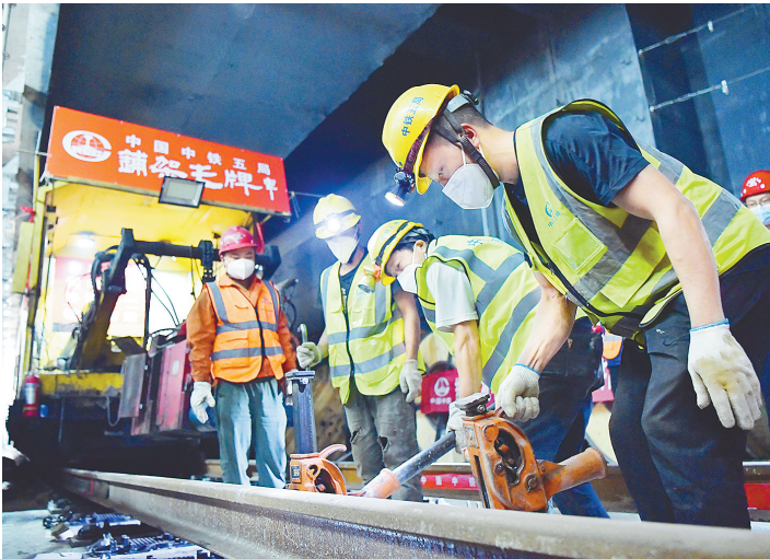
9月21日，中铁路工人在郑州市域铁路郑州段进行焊轨作业准备工作。当日，郑（州）许（昌）市域铁路郑州段轨道贯通。郑许市域铁路工程又称郑州机场至许昌市城市轨道交通工程，是一条连接郑州市与许昌市的城市轨道交通系统，全长67.13公里，设计时速120公里。 新华社记者 李嘉南 摄
