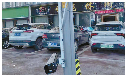
解放路大桥南向西路北,摄像头掉了下来。
