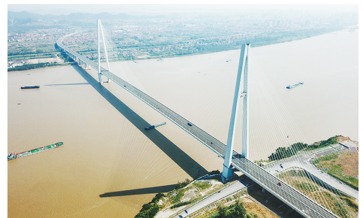
9月25日,汽车从武穴长江公路大桥上驶过(无人机照片)。新华社记者 程敏摄
