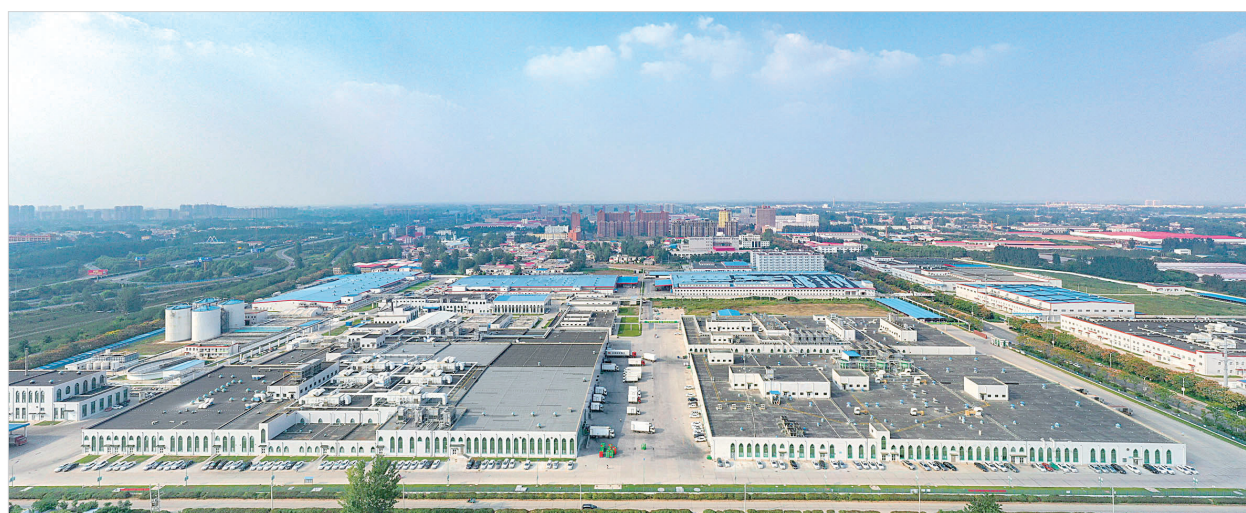
双汇第二工业园
