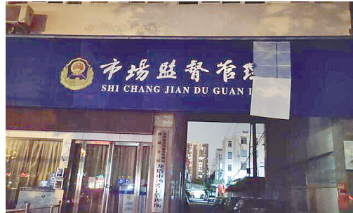
黄河广场附近，龙塔市场监督管理所门头破损。
