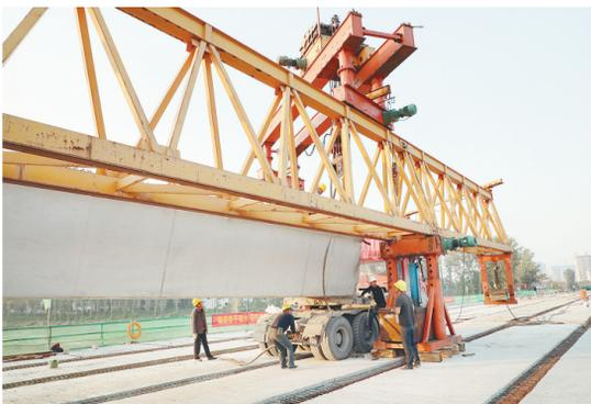
10月14日，五台山路漯河桥正在紧张施工中。该桥全长660米，其中主桥长210米，路面宽28米，两侧人行道各宽3.5米，预计2022年2月底建成通车。 本报记者 张佩 摄
