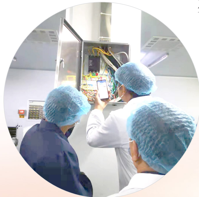
电力专家对企业电路进行安全检查
