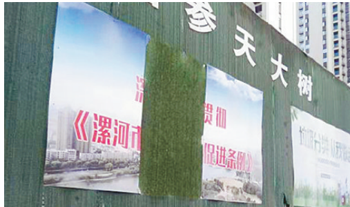
黄山路与会展路交叉口向南约30米路东，公益广告宣传板破损。
