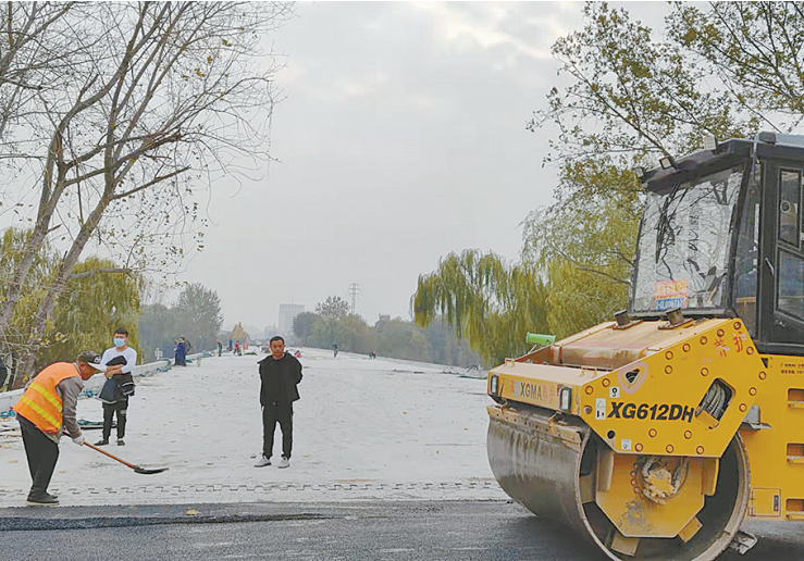
11月20日，施工人员在市区金山路沙河桥开展项目收尾工作。相关负责人告诉记者，金山路沙河桥维修加固项目于今年6月1日开工，预计11月底完工。 见习记者 王嘉明 摄
