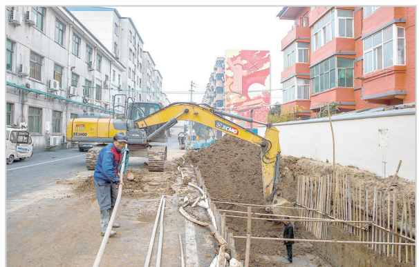
润泽园小区修建了系站,解决了内涝问题。 本报记者 杨光 摄
