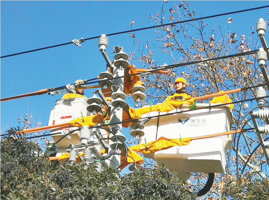
12月20日，市区黄河路，工人对电力设备进行升级改造。为保障冬季安全供电，连日来，漯河供电公司组织人员对电力设备进行检修、维护、升级。
