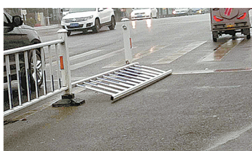
祁山路与淞江路交叉,交通护栏倒地。
