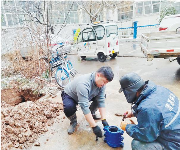
1月21日下午4时许,雨雪交加,漯河清源供水有限公司管网的维修员在市区大学路广电家属院抢修水管。
