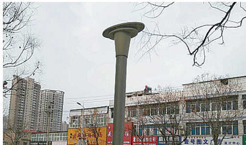
太行山北路与黄河西路交叉口东南角，路名牌缺失。
