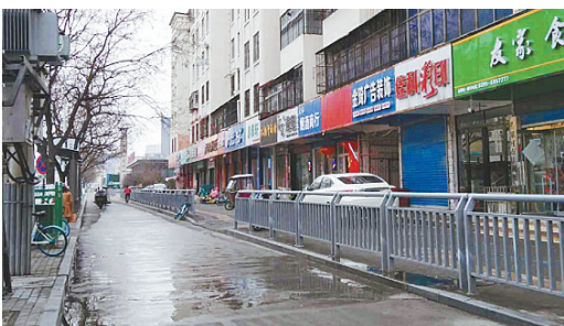
人民路与泰山路交叉口,污水井往外冒水。
