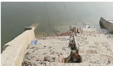
沙澧河风景区京广铁路下穿桥涵西侧,台阶破损。
