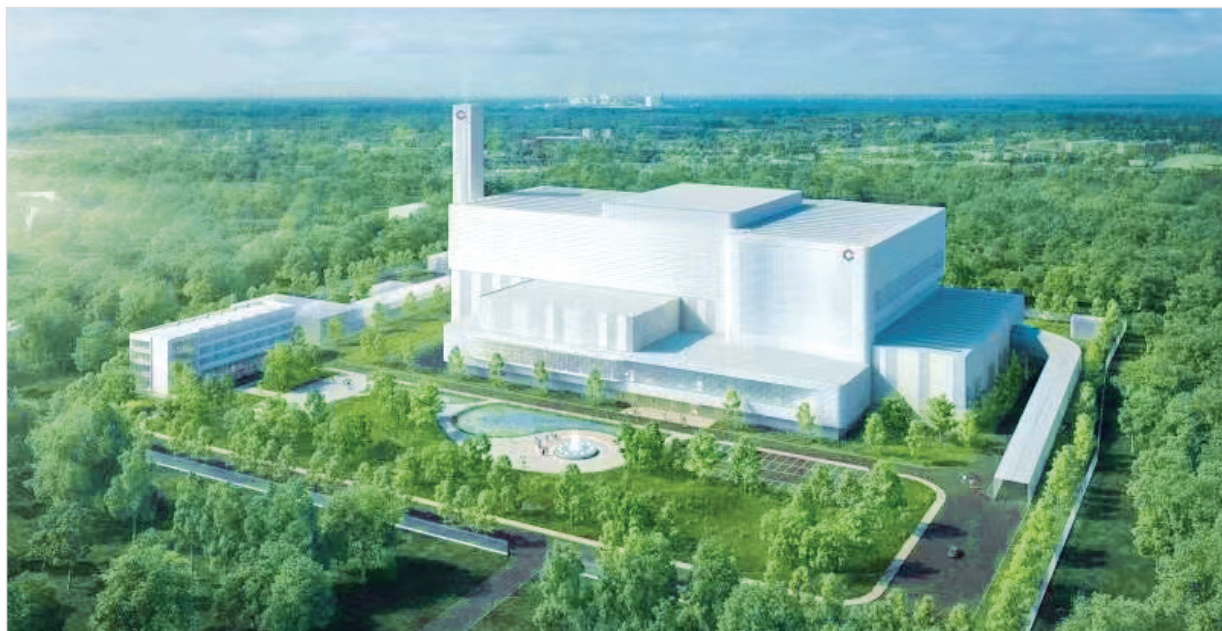
2021年11月10日,我市生活垃圾焚烧发电项目试运行期间首次并网发电成功。
