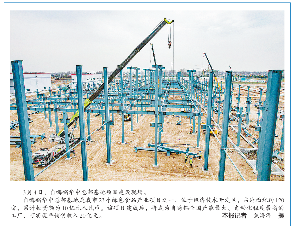
3月4日,自嗨锅华中总部基地项目建设现场。自嗨锅华中总部基地是我市23个绿色食品产业项目之一,位于经济技术开发区,占地面积约120亩,累计投资额为10亿元人民币。该项目建成后,将成为自嗨锅全国产能最大、自动化程度最高的工厂,可实现年销售收入20亿元。 本报记者 焦海洋 摄
