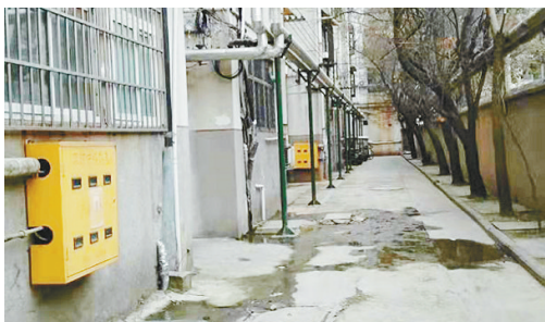
泰山路与海河路交叉口附近农行家属院，下水道堵塞，污水外溢。
