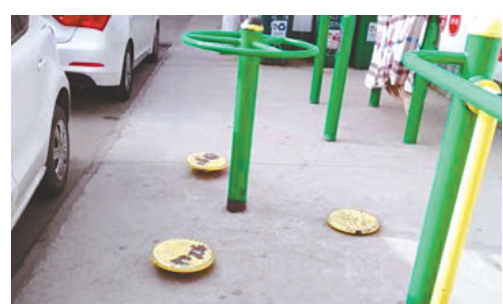
新风胡同与湘江西路交叉口向北约30米路西,健身器材损坏。
