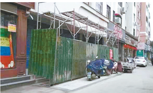
辽河路与嵩山北路交叉口向东50米路南,临街门店装修施工围挡无占道审批公示牌。
