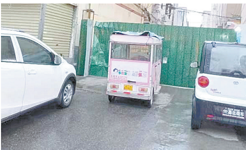
柳江路与嵩山南路交叉口向西60米路南,姬崔村防疫围挡破损。
