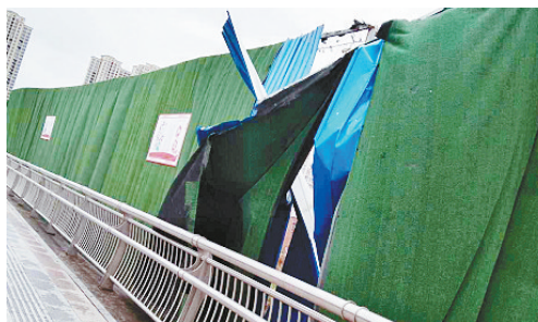
解放北路与黄河中路交叉口向南60米至100米之间,路两侧围挡破损。
