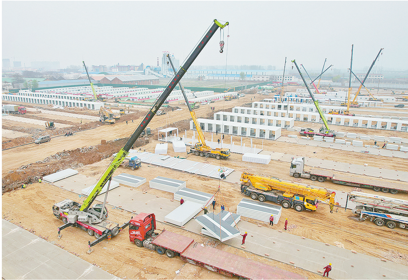
3月30日下午,在临颍县隔离专用房建设工地,工人们加紧施工。
