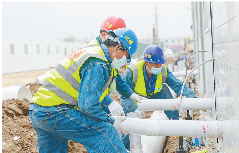
安装排水管道。
