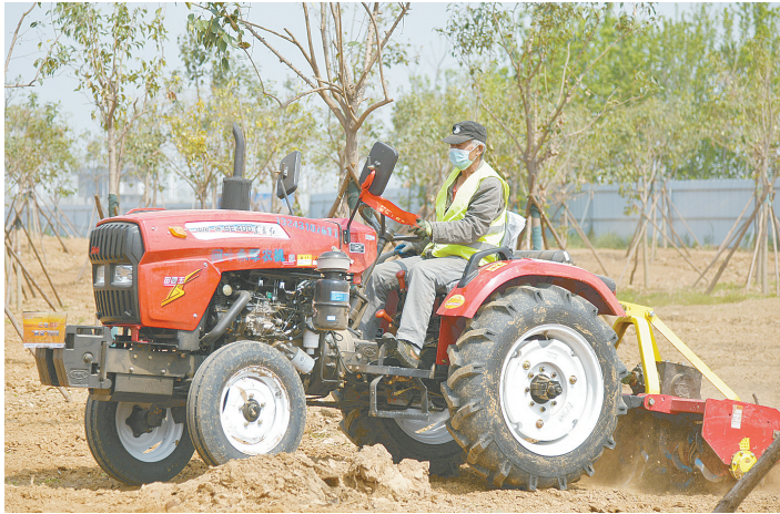
4月6日，漯河景观工程、漯河上游进水闸项目部施工现场，工人们戴着口罩忙作业。 本报记者 李宜书 摄
