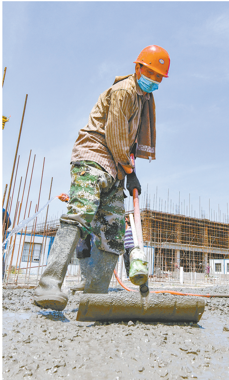
“五一”假期,在漯河食品职业学院,建筑工人在项目工地施工。 本报记者 焦海洋 摄
