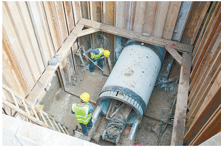
施工人员在市区嵩山路南段的雨污分流项目工地加紧施工。
